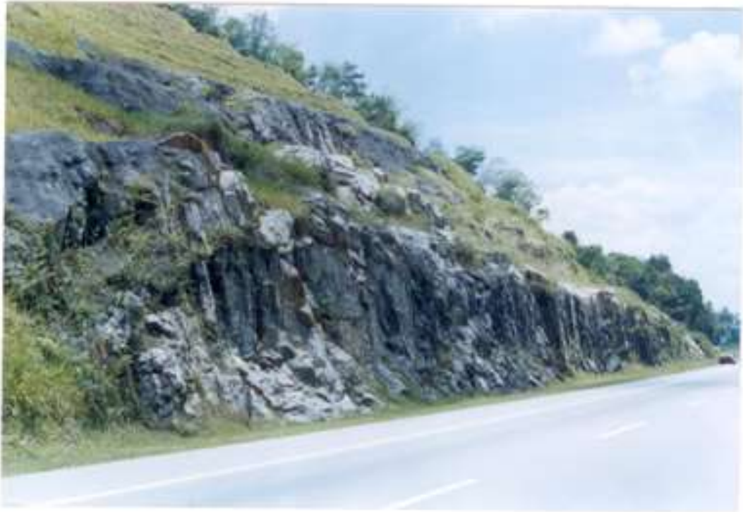
Gambar 2 : Menunjukkan sebahagian tapak kajian Cerun B : (KM 173.7 – jalan hala ke Selatan)
